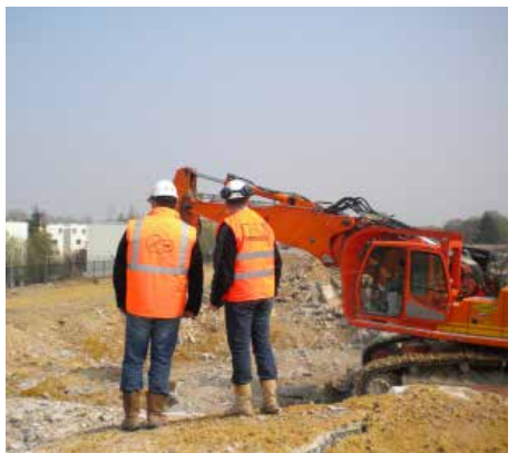
phase de démolition
