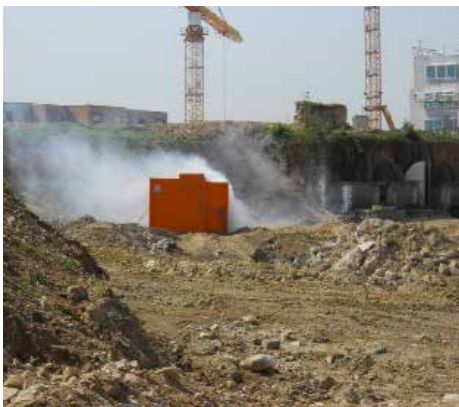
mise-à-jour et destruction sous protection balistique
