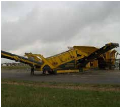
Concassage des dalles de béton
