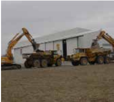
Méthodologie sécurisée pour l'enlèvement des dalles
