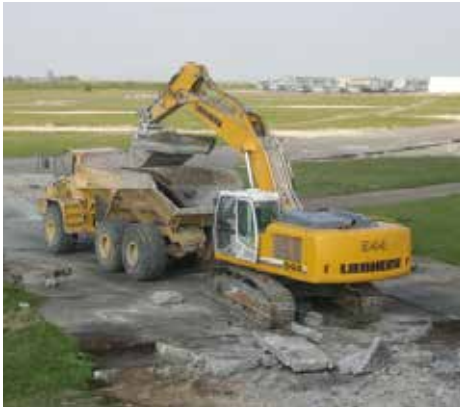
Destruction des structures avant concassage
