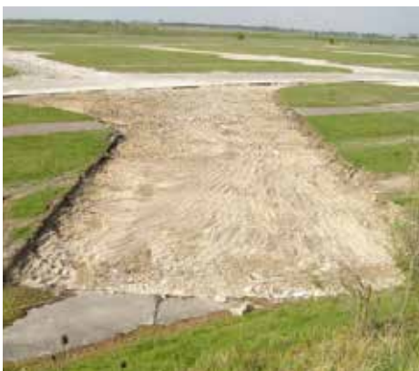
Alvéole après enlèvement des dalles
