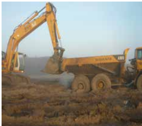
Déconstruction sécurisée des merlons validée par ESP
